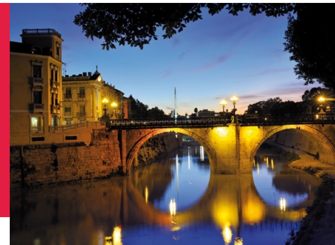
Puente de los Peligros
